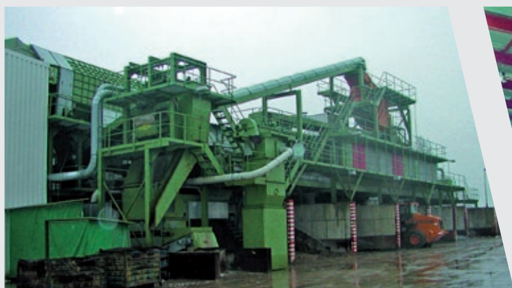
Tri automatique ZENO des gravats de construction et tri de déchets industriels
