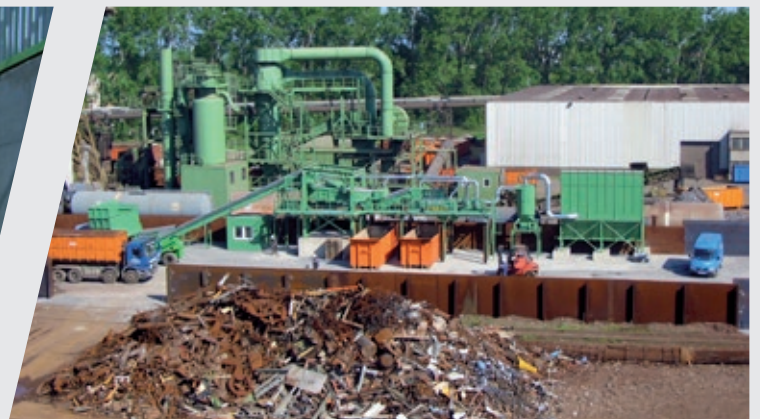
Installation de traitement et de dosage ZENO
