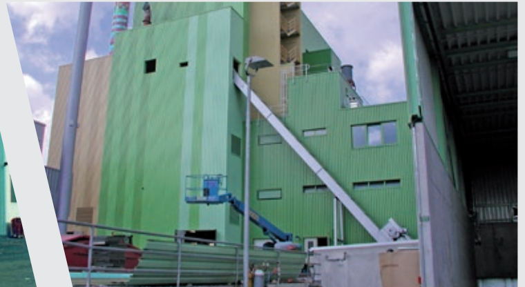
Équipement de tri, dosage et système de chargement pour chaufferie biomasse ZENO
