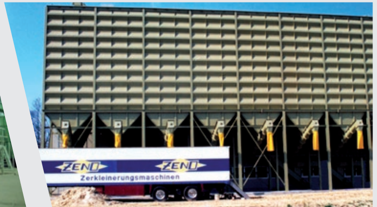
Silo agglomérat ZENO, capacité 2.000 m 3
