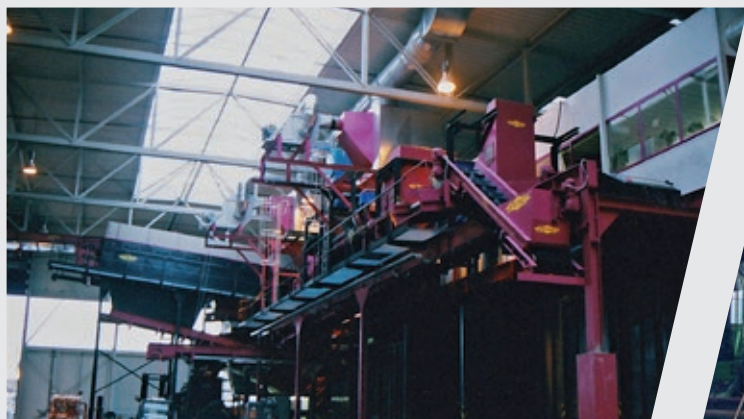
Triage DSD de dernière technologie, capacité : 8 t/h
