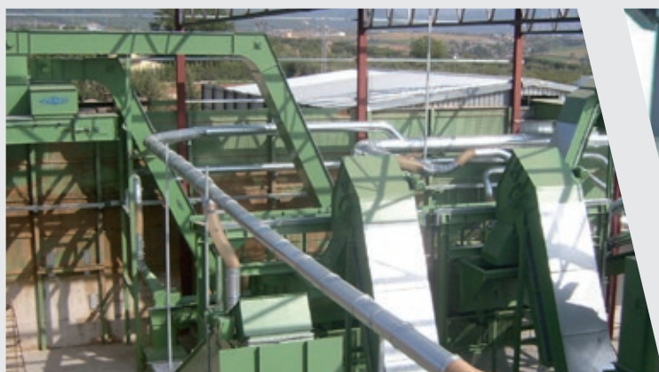
Traitement des restes de bois, pré- et post-broyage ZENO
